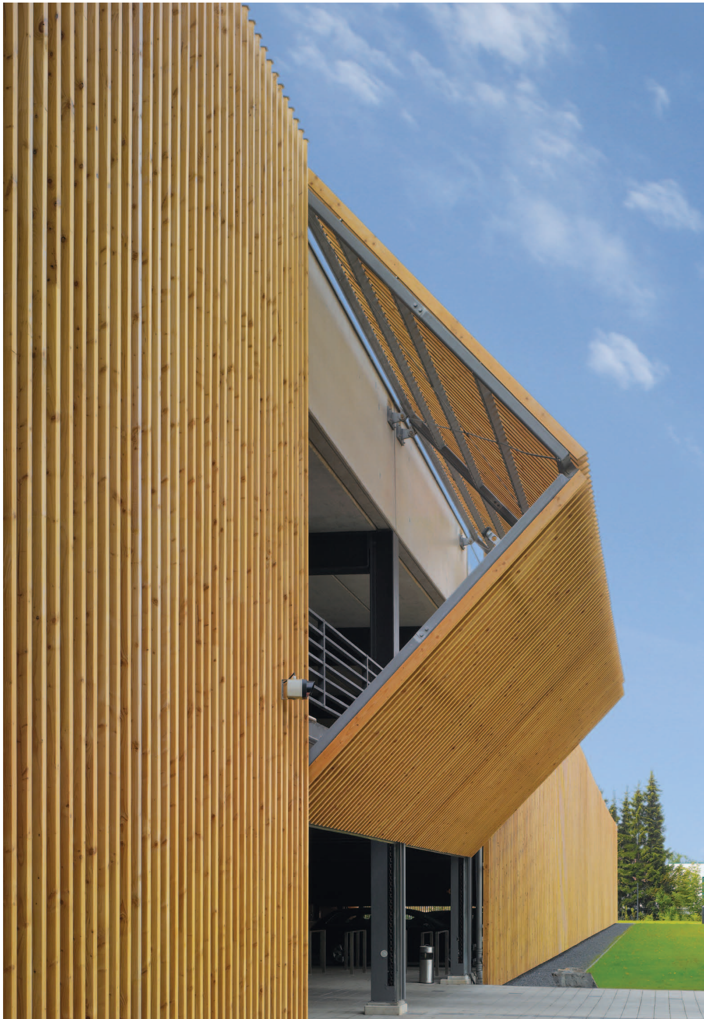
Doppelgängige Parkrampe ||||| Lichteinfall, Ein- und Ausfahrt
