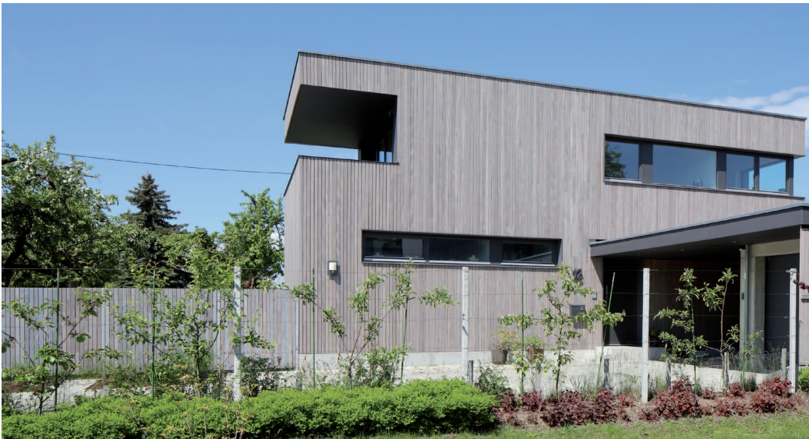
Abgrenzung ||||| An den gewinkelten Baukörper schließen sich Zufahrt und Garage an
