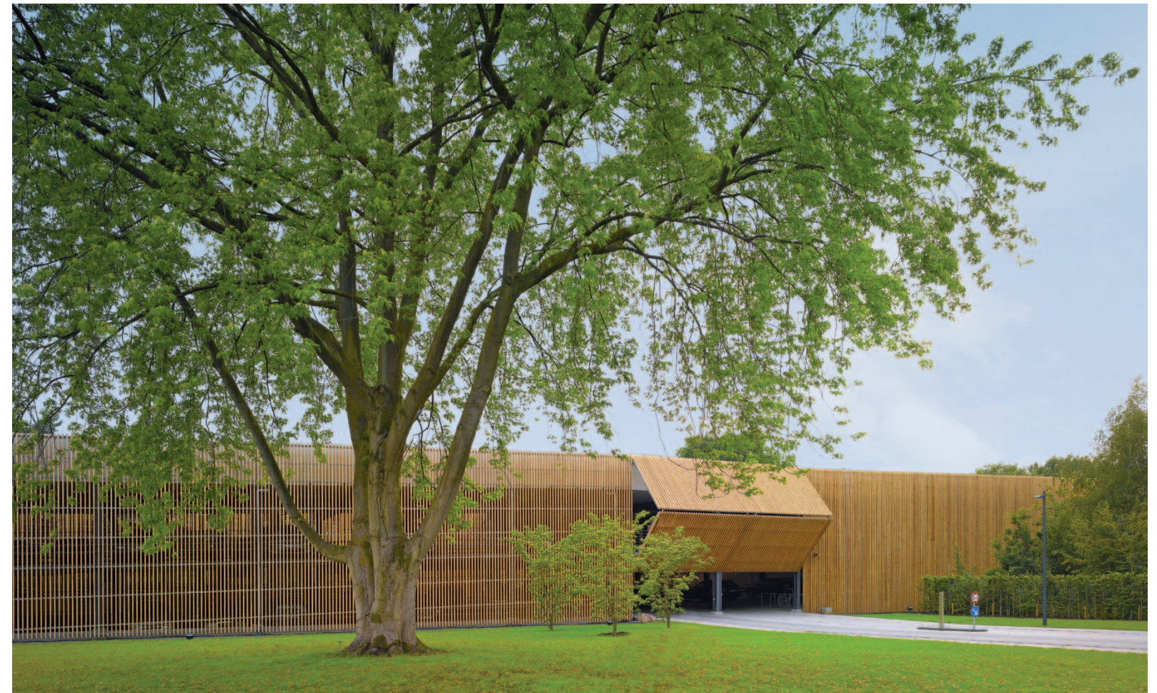
Verwurzelt ||||| Die Holzfassade der Gebäudehülle wirkt harmonisch verankert im Geländeverlauf
