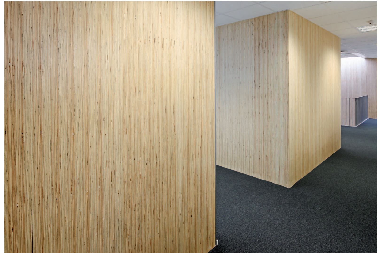
Funktion im Blickpunkt ||||| Aufzugs- und Versorgungsschacht aus massivem Brettsperholz mit LVL-Furnierschichtholz in FineLine-Optik
