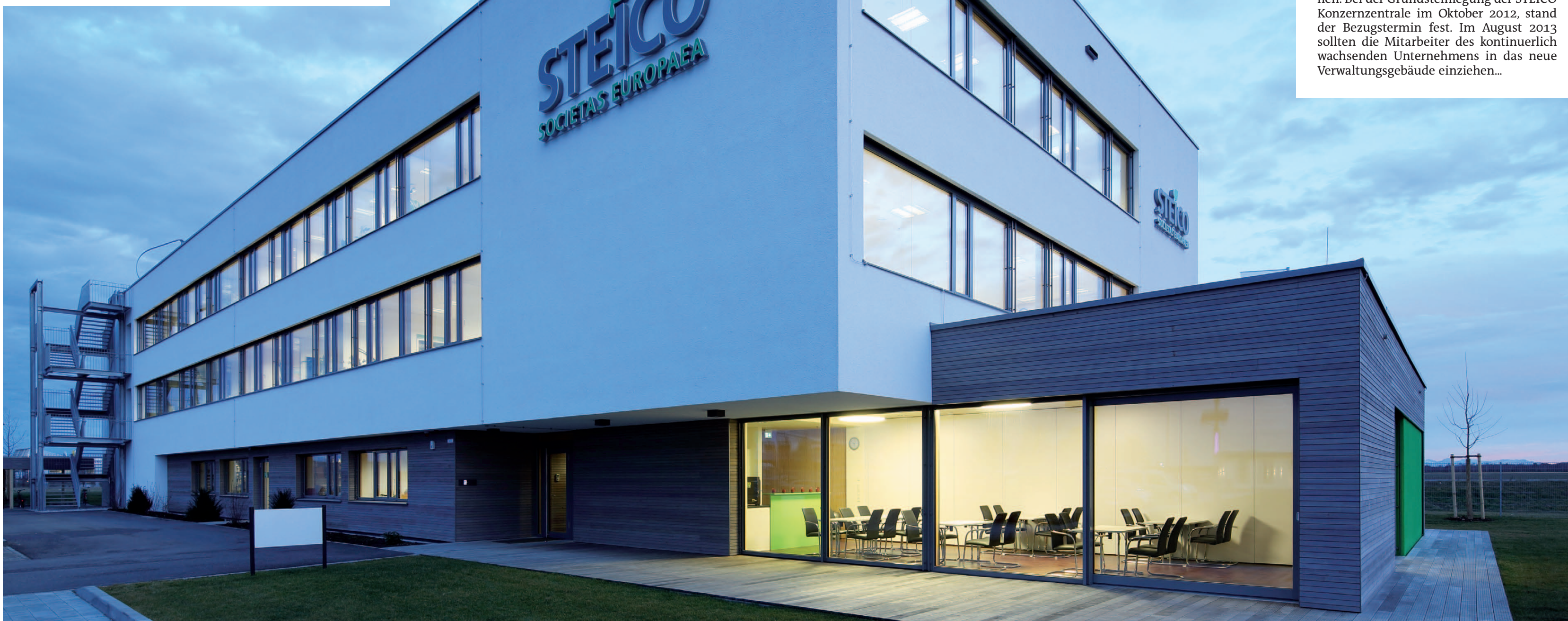
Über den Winter gebaut ||||| im August 2013 war die STEICO Firmenzentrale bezugsfertig ||||| Foto: Conné van d'Grachten
