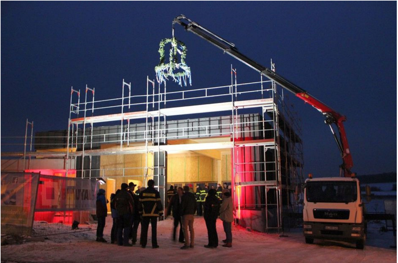
Richtfest am Feuerwehrhaus Markbronn © Foto: Stadt Blaustein
