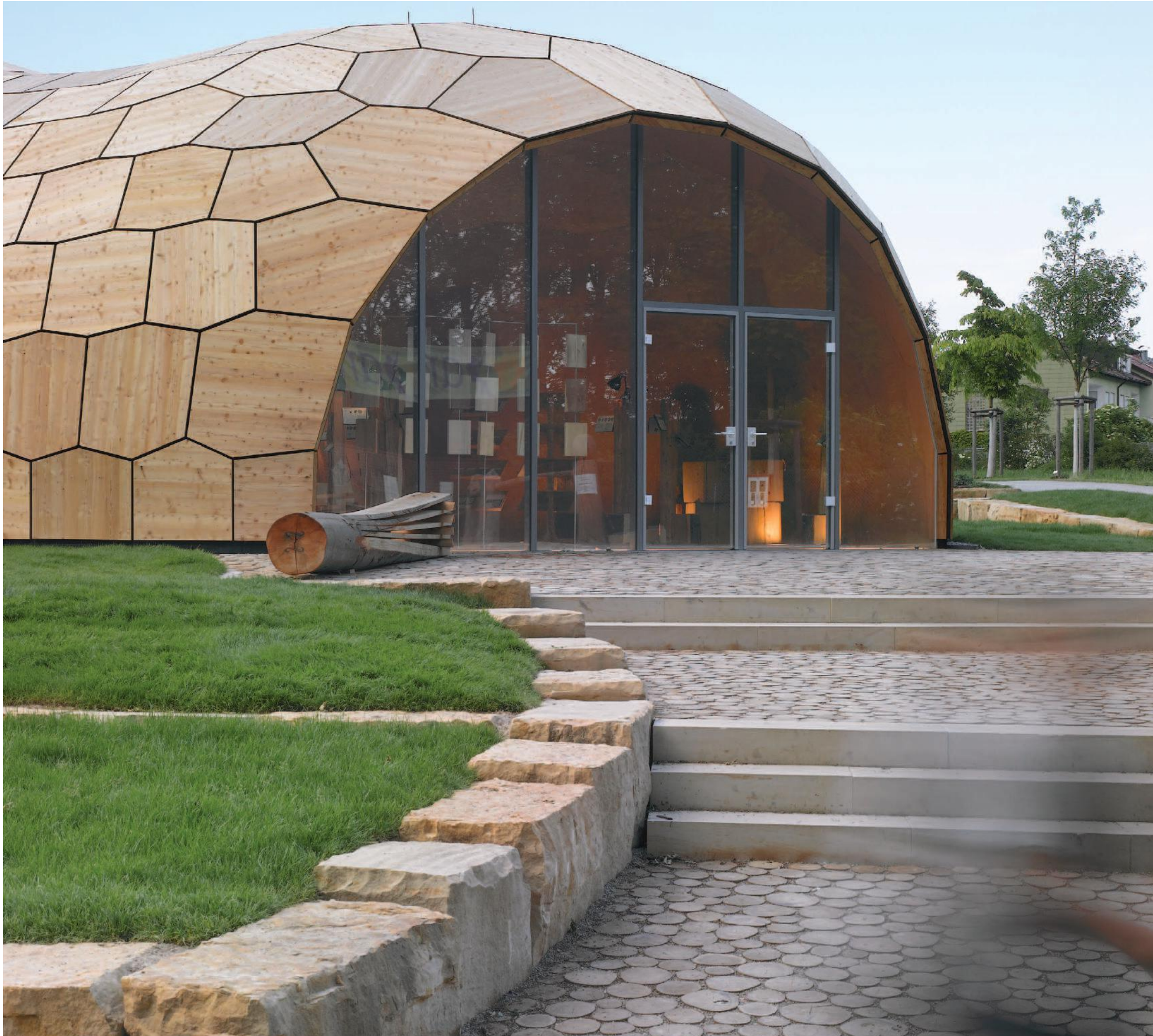
Die verglaste Eingangssituation zieht magisch an ■■■ Der weitläufige Treppenaufgang weist den Weg ins Innere ■■■ Foto: Roland Halbe
